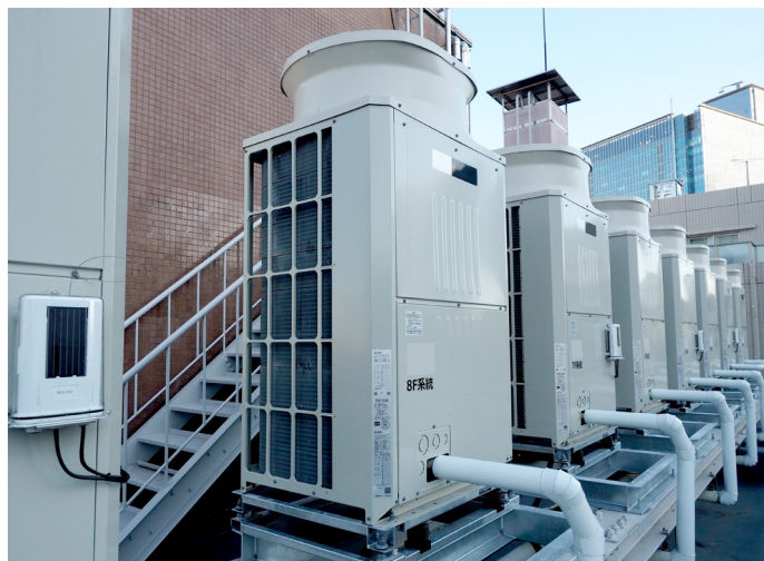
屋上に並んだ空調の室外機。左手前に見える白いボックスがEMSの制御子機
